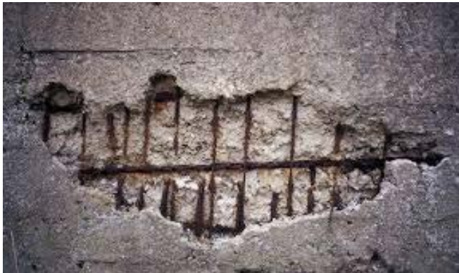
Figura 22. Exemplo de lascamento explosivo
